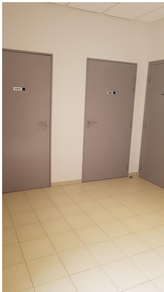
Hall d'entrée – vue accès toilettes
