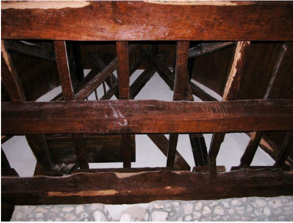
détail charpente soutenant le clocher
